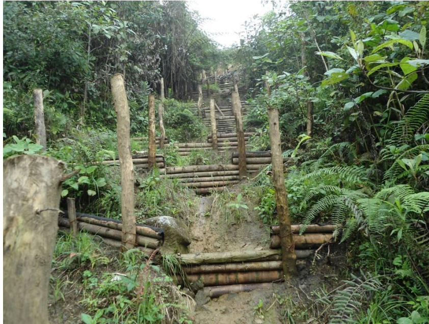
Obras de bioingeniería. Afluente quebrada Lulos. Ginebra.
