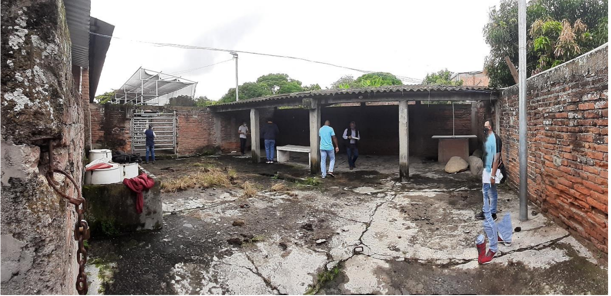
Imagen panorámica del Sitio a ser Adecuado
