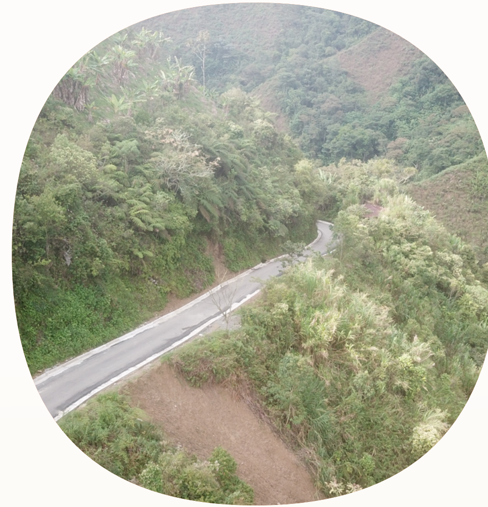
IMAGEN 12. Obras por impuestos.
