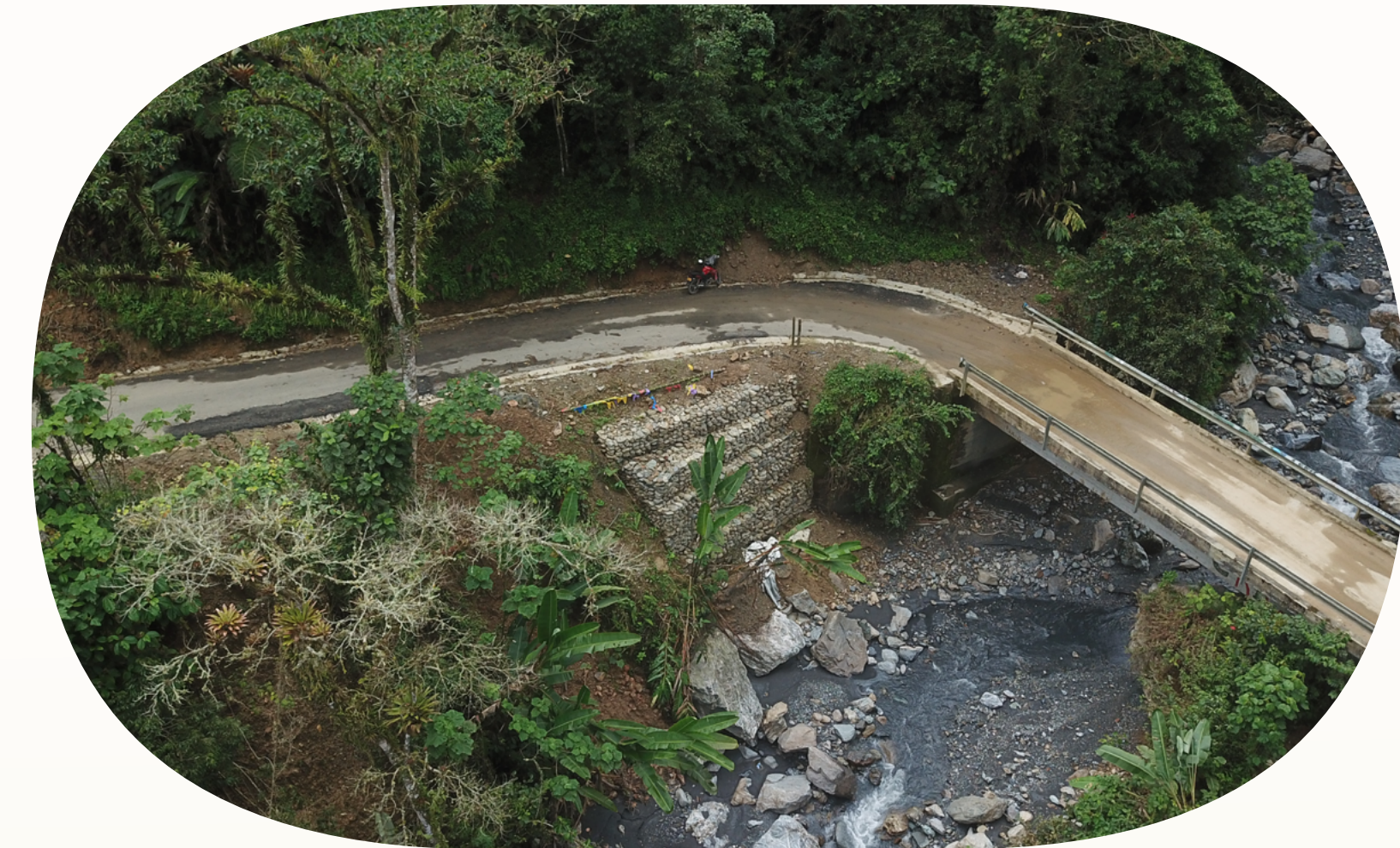
IMAGEN 13. Obras por impuestos.
