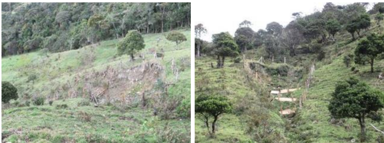
Aislamiento y trinchos implementados en el predio La Victoria
