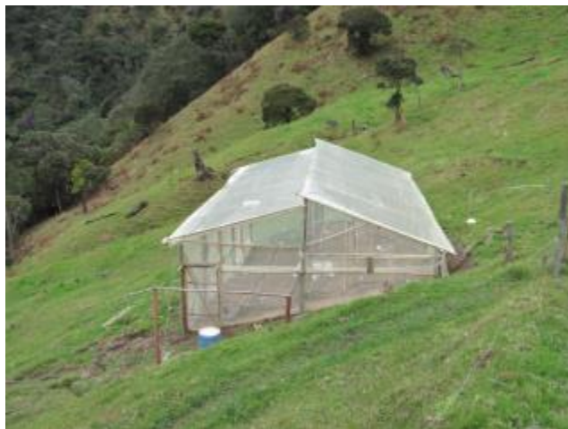
Construcción del invernadero piloto en el predio La Victoria
