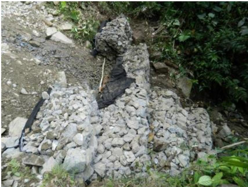
**Foto 25. Revestimiento de gaviones – quebrada La Cidreira**
