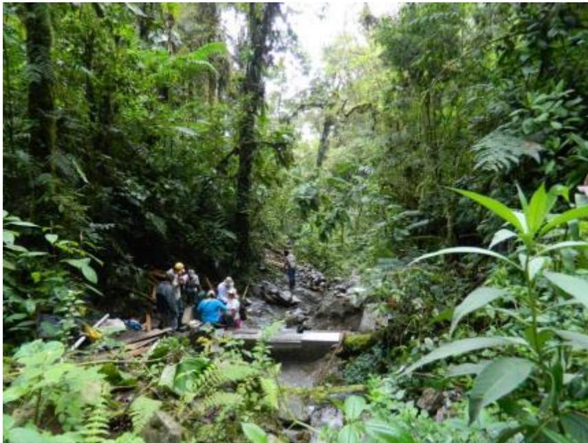
**Foto3. Construcción de gaviones para la protección de la bocatoma acueducto Moravia**
